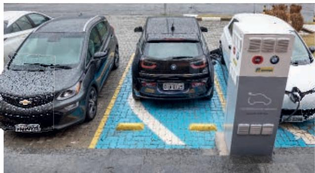
Os carregadores rápidos possuem tensão de até 500 volts e 120 amperes, mas cada tomada tem um fluxo diferente.
