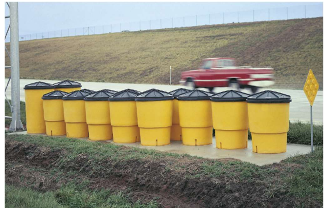
Figura 6: Exemplo de barreira de baldes com areia
